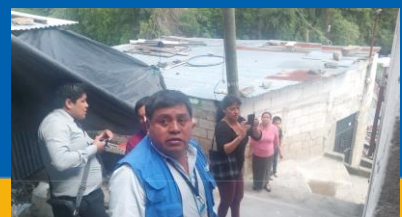
La vida de las familias que viven abajo del puente está en riesgo.
