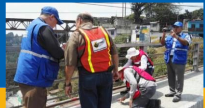
Trabajadores de la PDH dan acompañamiento a supervisiones en el puente.
